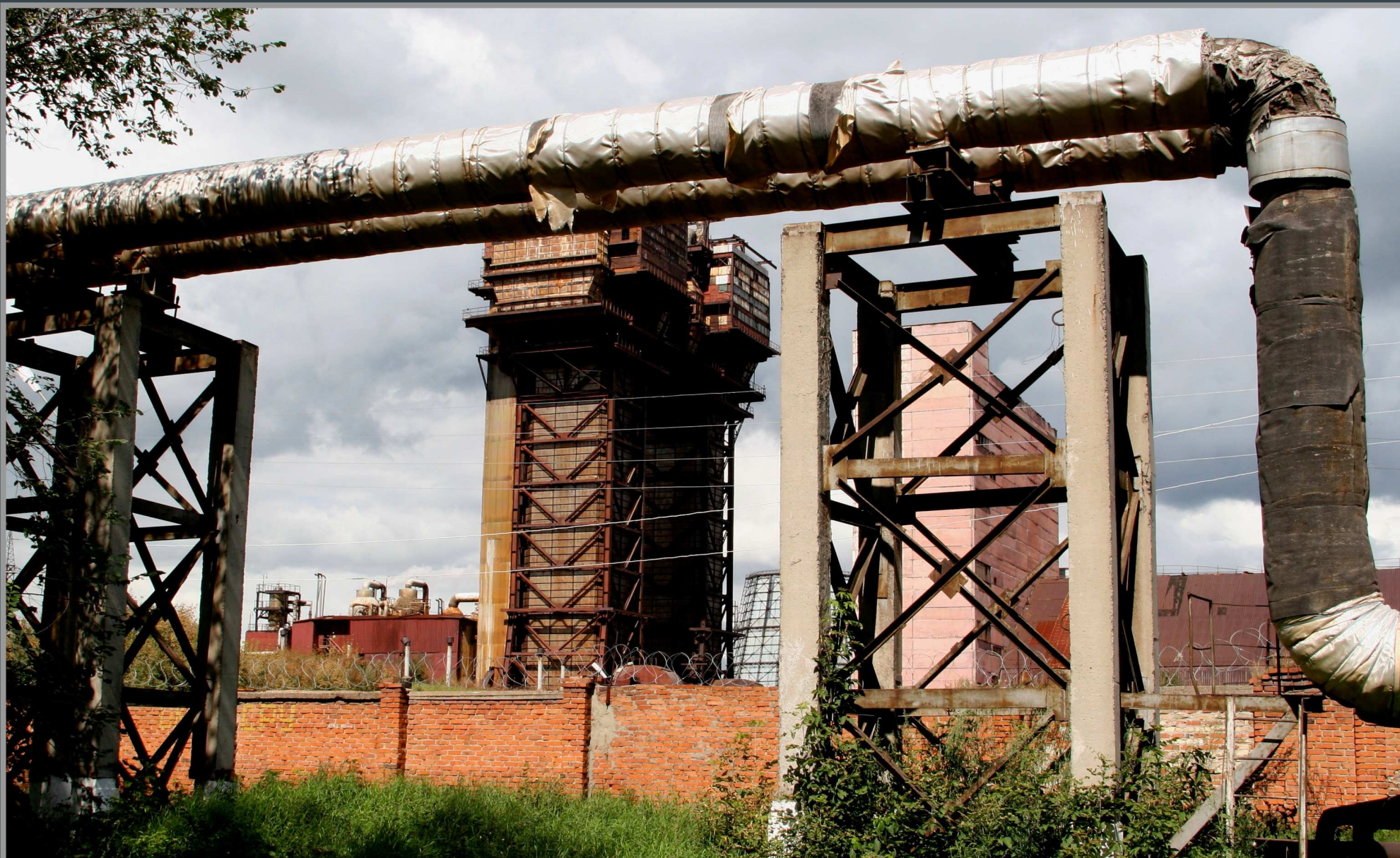
Tubazioni per gli scarichi del cementificio FEDERAZIONE RUSSA
